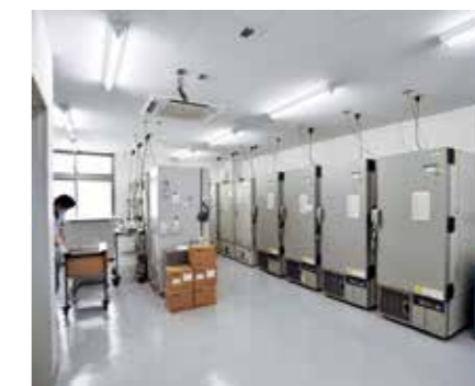
超低温冷凍庫(-80℃)専用室。計32台に3万点の生鮮凍結脳を収納し、デジタルデータベース管理しています。
